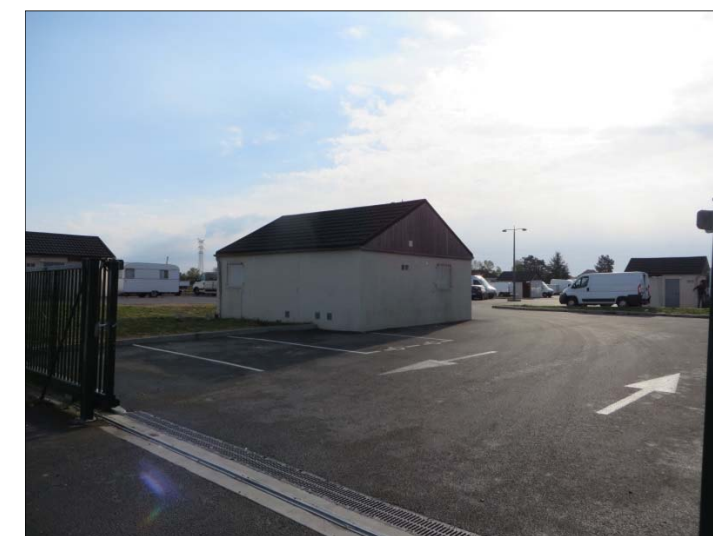
Figure 59 : Aire d'accueil de gens du voyage Beaulieu à Poitiers (Source : setec international)
