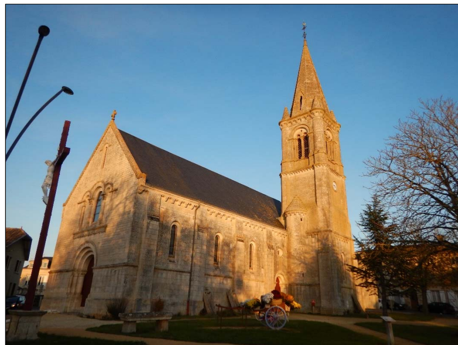
Figure 47 : Eglise de Montamisé
