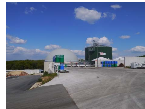
Figure 64 : Zone de méthanisation du GAEC de la Baie des Champs (Source : setec international)
