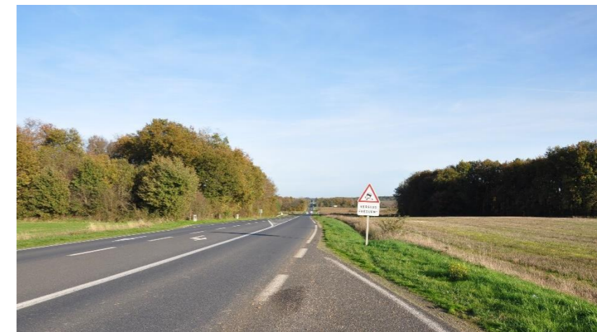
RN 151 – Intersection avec la route de Beauvoir – St-Julien l'Ars – Source TAUW
