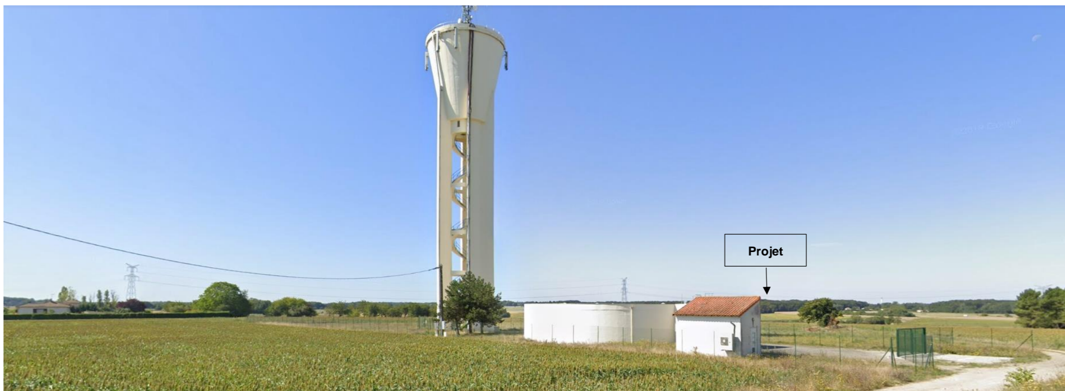
Vue 14 : Vue du projet depuis la route de Casse-Cou (D 951), à hauteur du château d'eau de Sèvres-Anxaumont. Zone boisée entre l'axe routier et le projet limitant toute perception visuelle.
