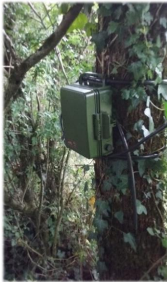
Figure 3 : Installation d'enregistreur continu SM4BAT © NCA Environnement
